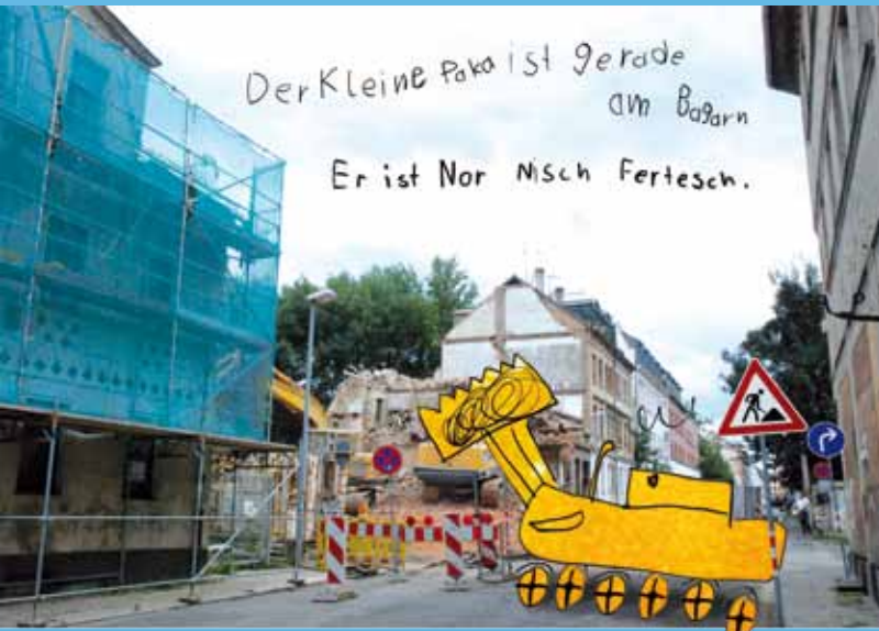
Abbrucharbeiten auf dem zukünftigen Kindergartengrundstück in der Josephstraße
