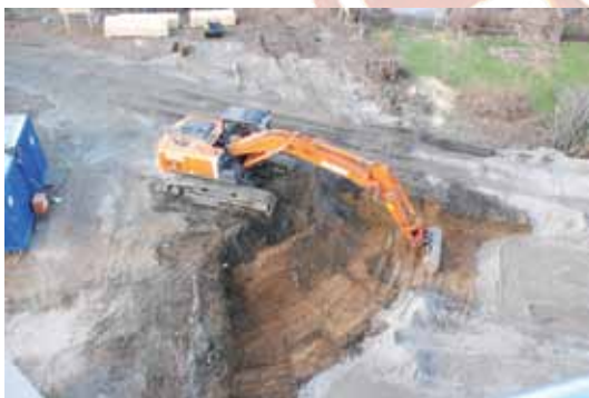
Fund-am-Ente? Nach dem Erdaushub...
